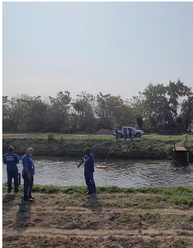
Canal desarenador da ETA Laranjal.
