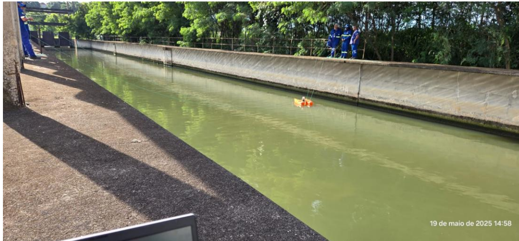
Canal desarenador da ETA Guandu Medição.
