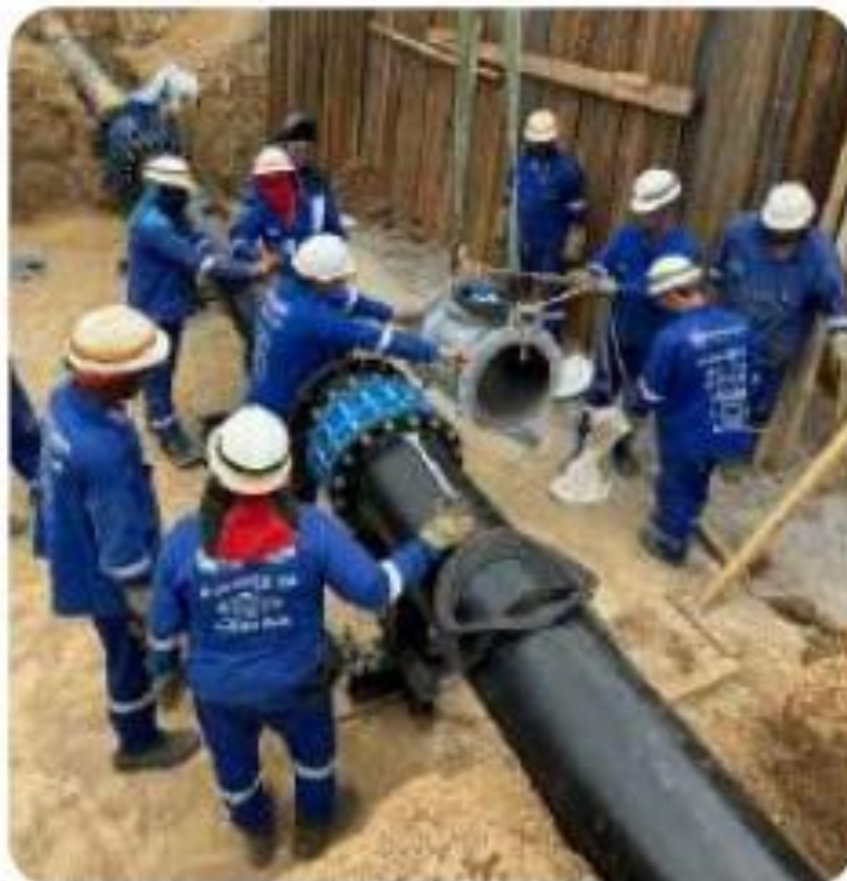
Fotos: Implantação do sistema de macromedição de vazão nas adutoras da Cedae
